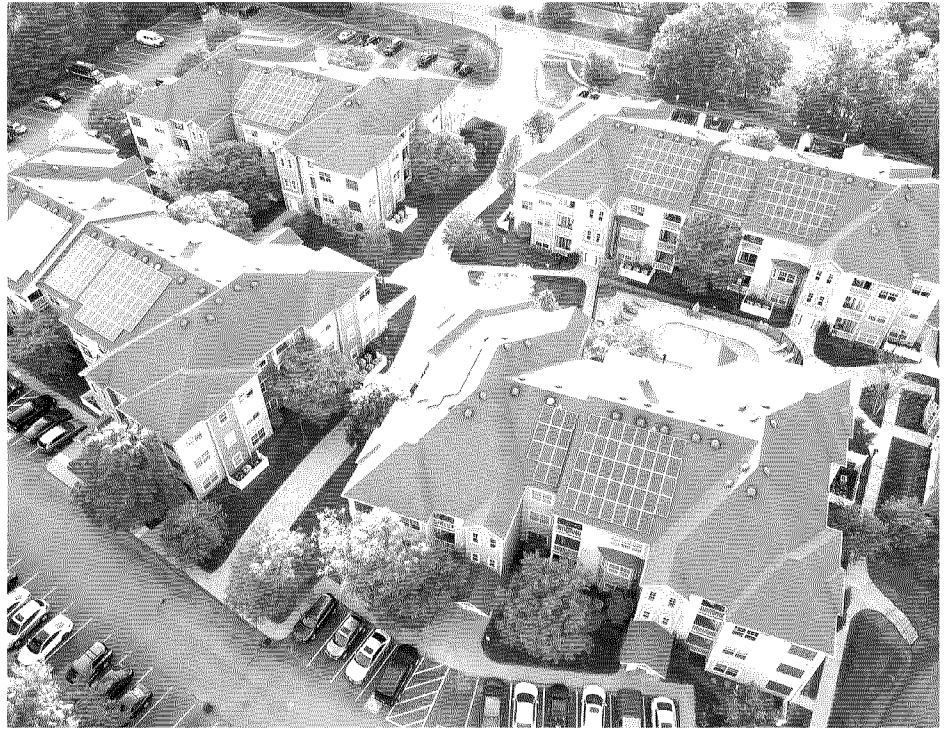
Fonti rinnovabili. Un gruppo di unità residenziali accomunate dallo stesso obiettivo: ricavare energia dalla luce solare attraverso i pannelli fotovoltaici installati sui tetti
