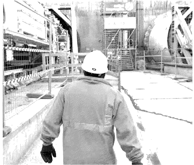
Le opere chiave. Nell'immagine i lavori di realizzazione del Terzo Valico
