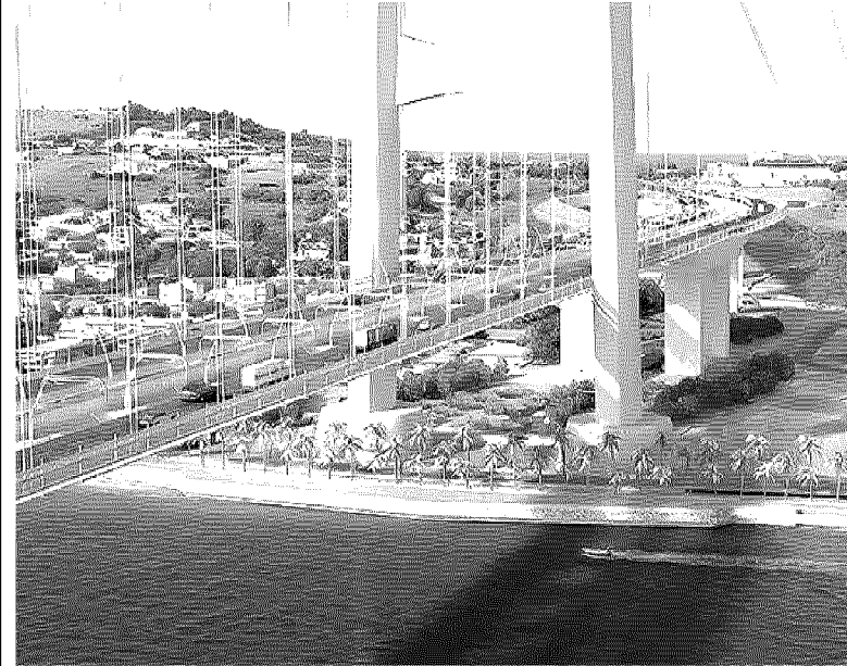
Il progetto. Il rendering del Ponte sullo Stretto: è a campata unica e lungo 3,6 km
