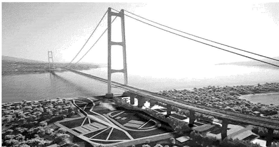
Il rendering del Ponte sullo Stretto di Messina: il progetto prevede una campata unica di 3,3 km con 6 corsie stradali e due binari ferroviari e una lunghezza complessiva di 6,6 km
