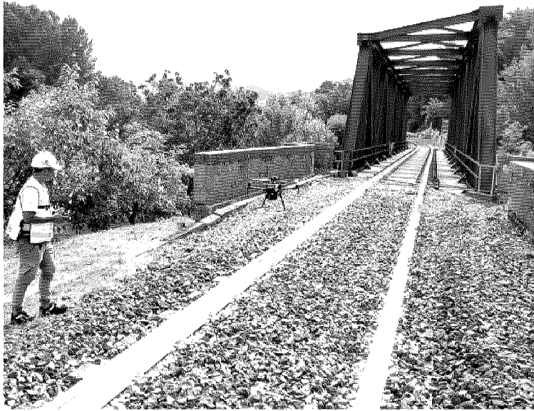
Tecnologie per la sicurezza. Ispezione con un drone lungo la rete ferroviaria
