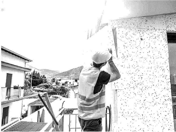
A rischio. Un cappotto progettato o installato male genera muffe e marcescenza
