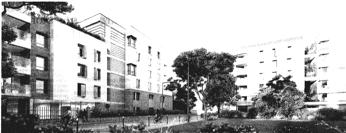
Fuori Parigi. Recygénie, il primo complesso immobiliare costruito interamente con calcestruzzo riciclato al 100%, sarà completato entro il 2024
