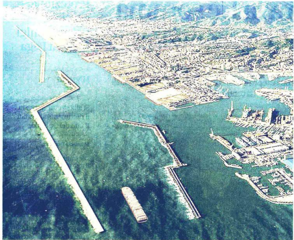
Il progetto. La nuova diga foranea del porto della Lanterna. La posa della prima pietra dell'opera avverrà il 4 maggio
