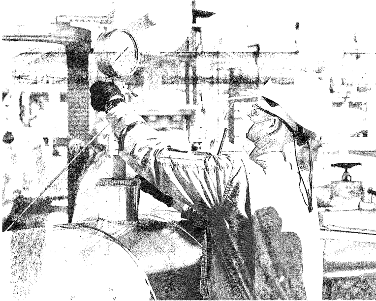
Infrastruttura. Uno dei terminali di ricezione del gasdotto Tap
