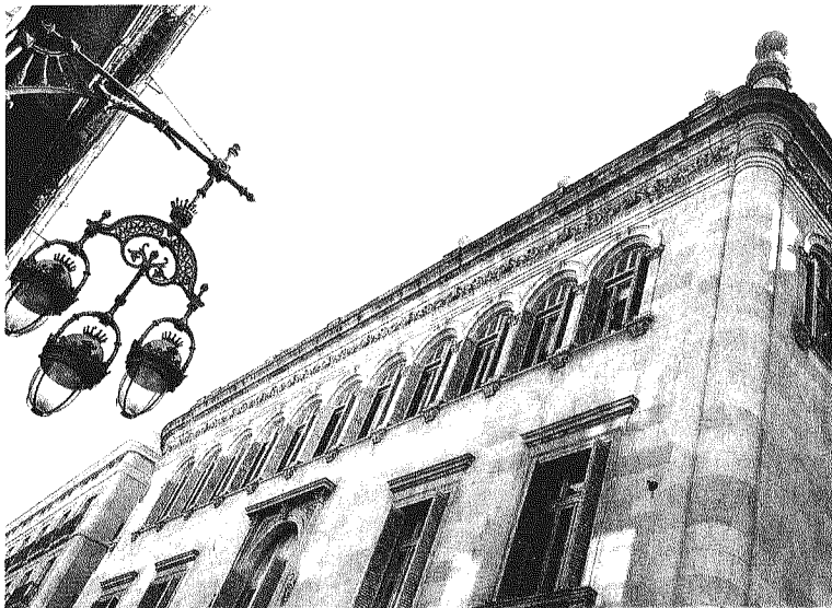
Esenzioni. Edifici dal particolare valore architettonico fuori dalla direttiva green
