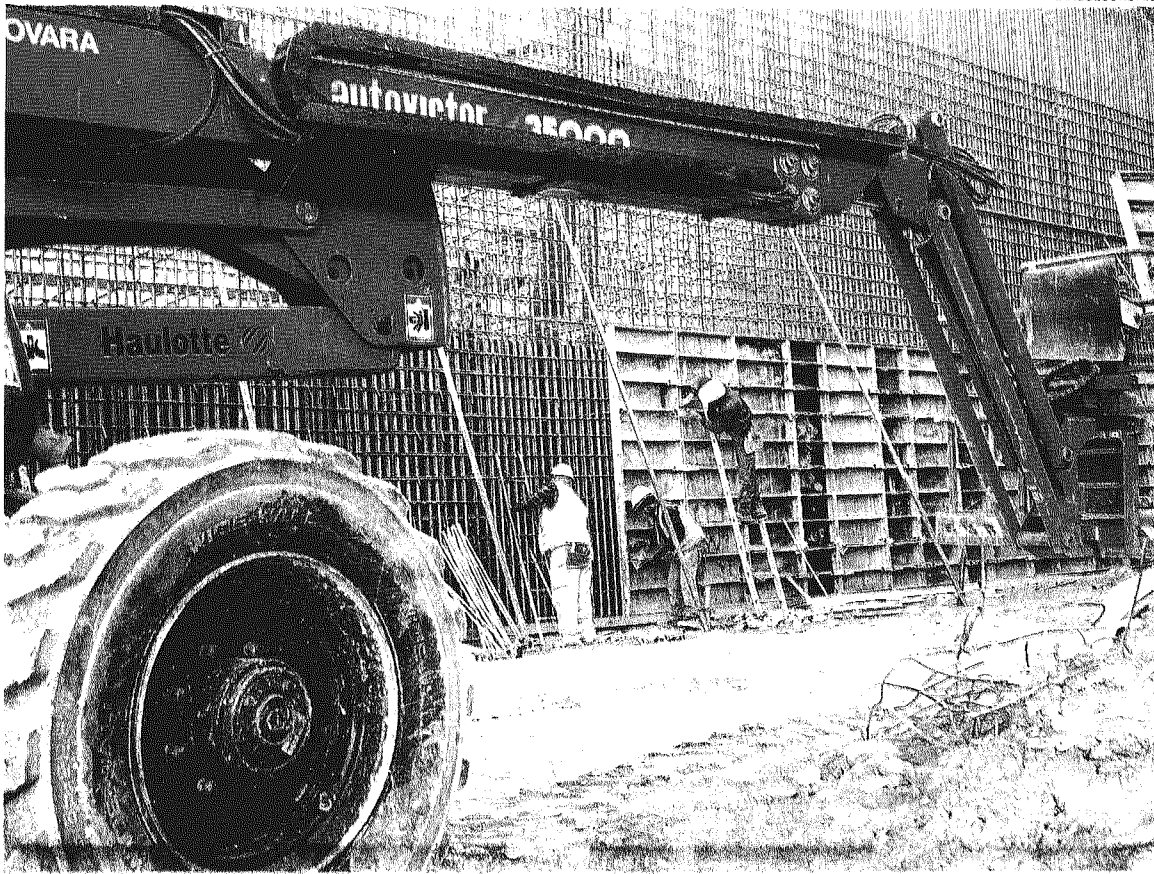
Il cantiere. Ieri la società Autostrada pedemontana lombarda ha firmato il contrat- to per la progetta- zione esecutiva
