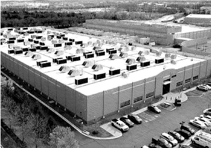
Virginia. Il Digital Realty Data Center di Ashburn
