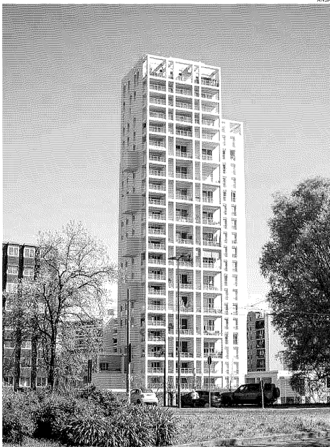
Torre Milano. Il palazzo di via Stresa sotto inchiesta a Milano
