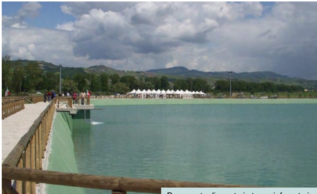
Paramento di monte in terra rinforzata impermeabilizzato
