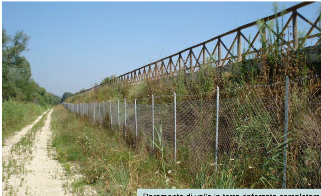
Paramento di valle in terra rinforzata completamente rinverdito
