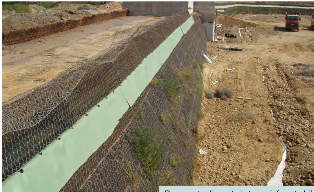
Paramento di monte in terra rinforzata bifacciale
