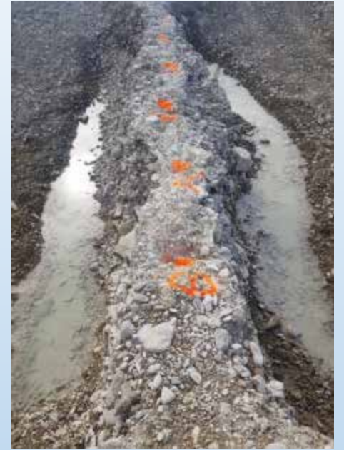
Campo prova schermo idraulico in jet grouting doppio-lamellare
