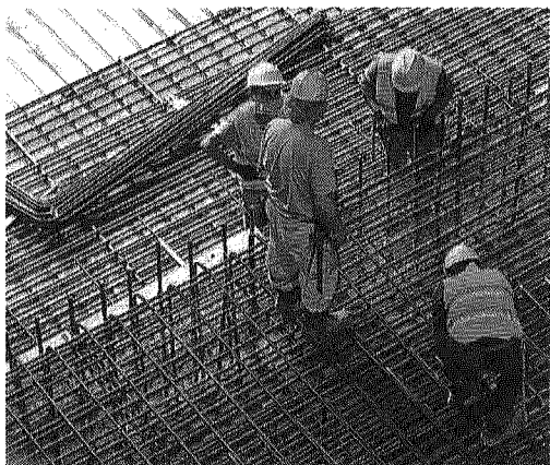
Cantiere Lavori in corso in un cantiere per la costruzione della linea Metro C a Roma
