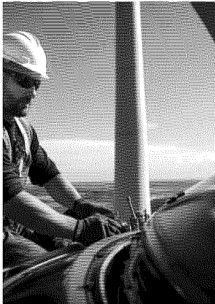
Operatore su pala eolica
