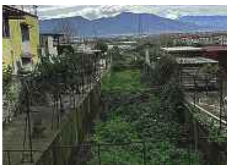
Dall'alto La vasca di contenimento costruita dopo la frana del 1998 ai piedi del Pizzo d'Alvano: erbacce e rifiuti invadono i canali pensati per mettere in sicurezza Sarno
