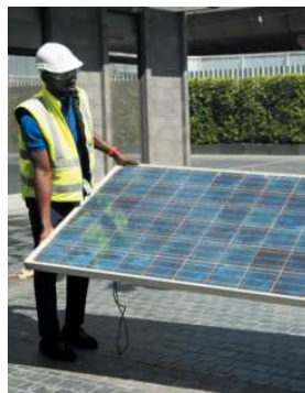
Installazione di un pannello
