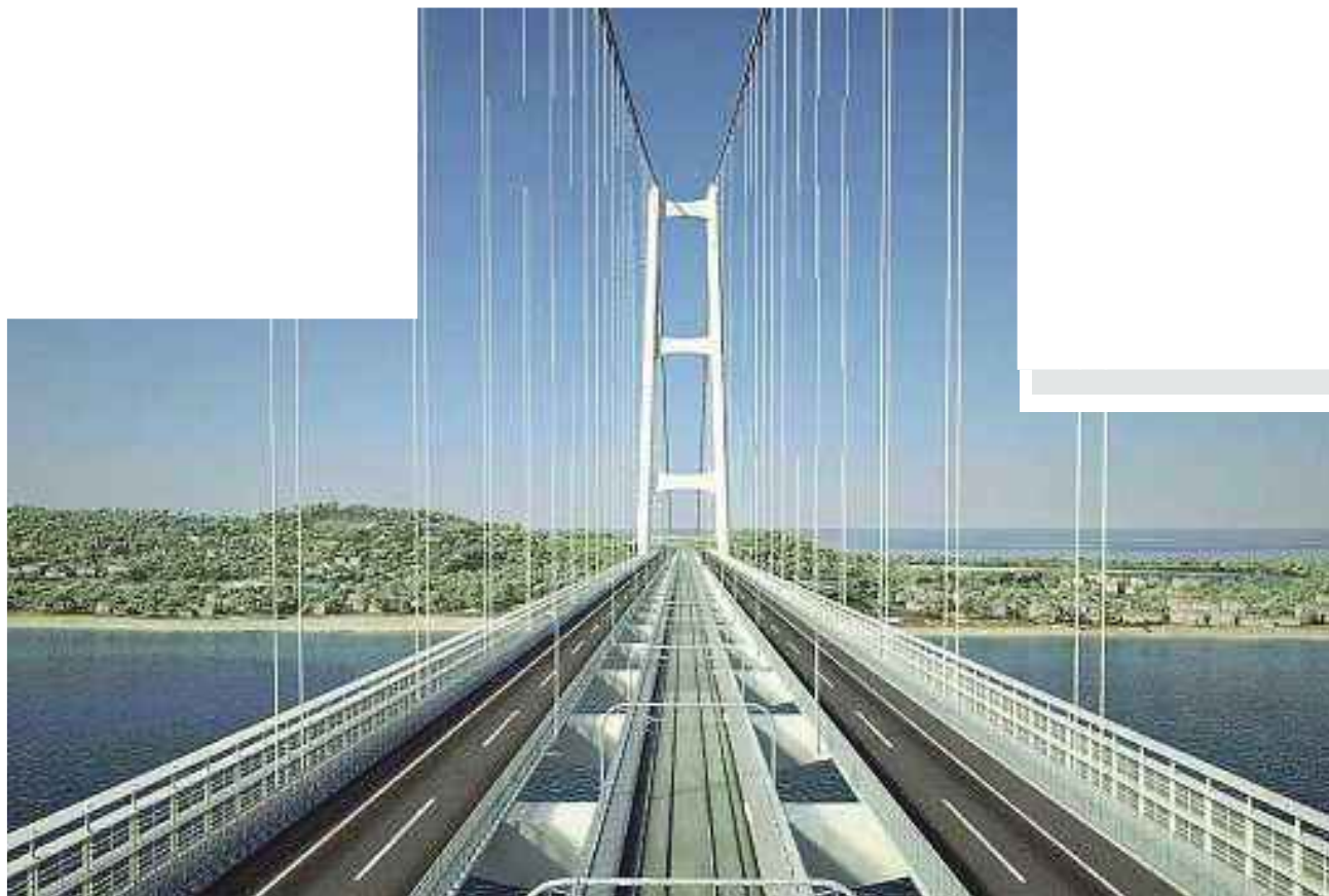
L'immagine del progetto del Ponte sullo Stretto di Messina, La lunghezza totale tra i giunti di espansione è di 3,6 chilometri
