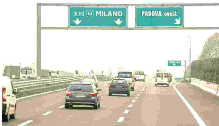
A4. Un tratto dell'Autostrada Brescia-Padova
