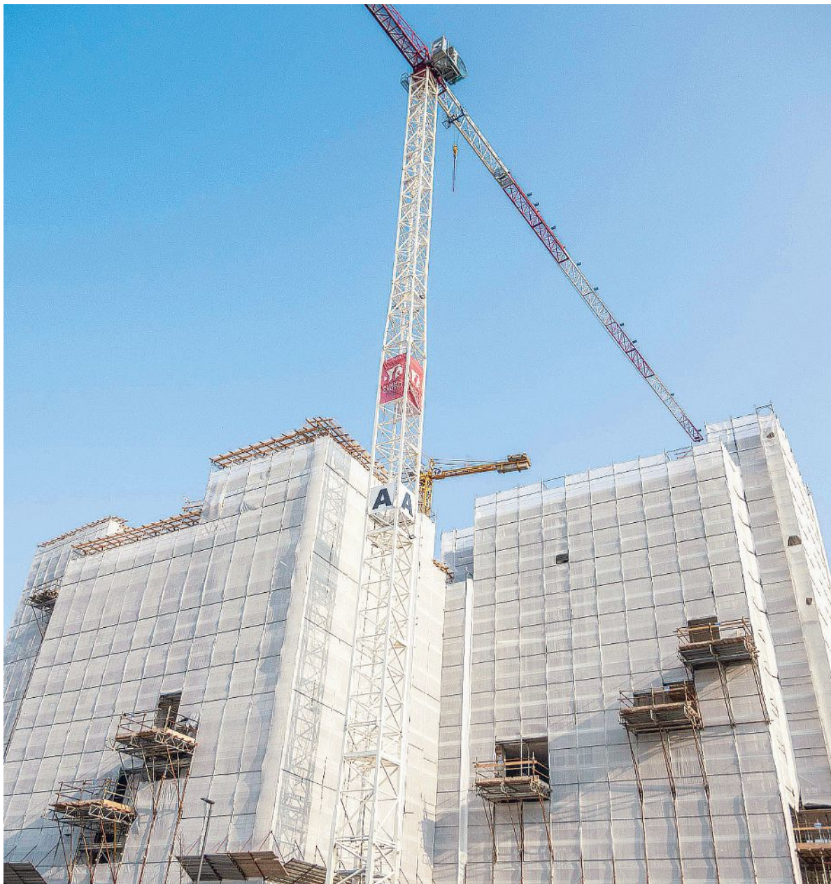
Il cantiere edilizio Residenze Lac a Milano messo sotto sequestro/Ansa
