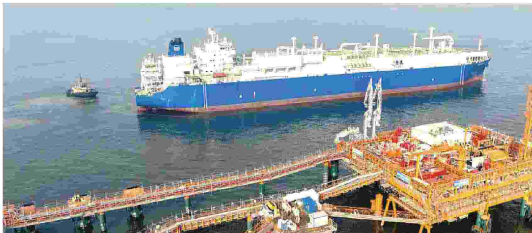
Infrastrutture. Il terminale di rigassificazione di Snam ormeggiato a Ravenna
