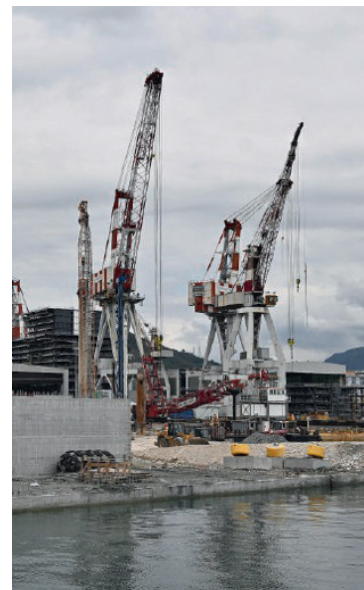
Costo: 1,6 mld I lavori della diga foranea
