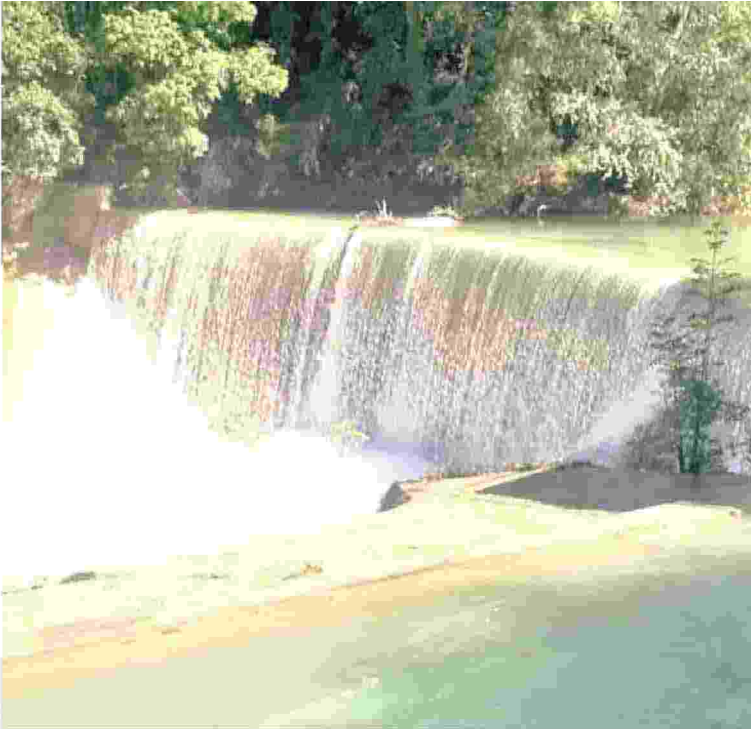
Nelle Marche. La centrale idroelettrica del Burano, nella località Pian delle Rose, in provincia di Pesaro
