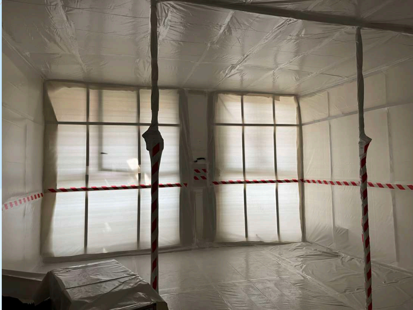
Ritrovamento tubazioni in amianto in più punti dell'edificio e successiva bonifica
