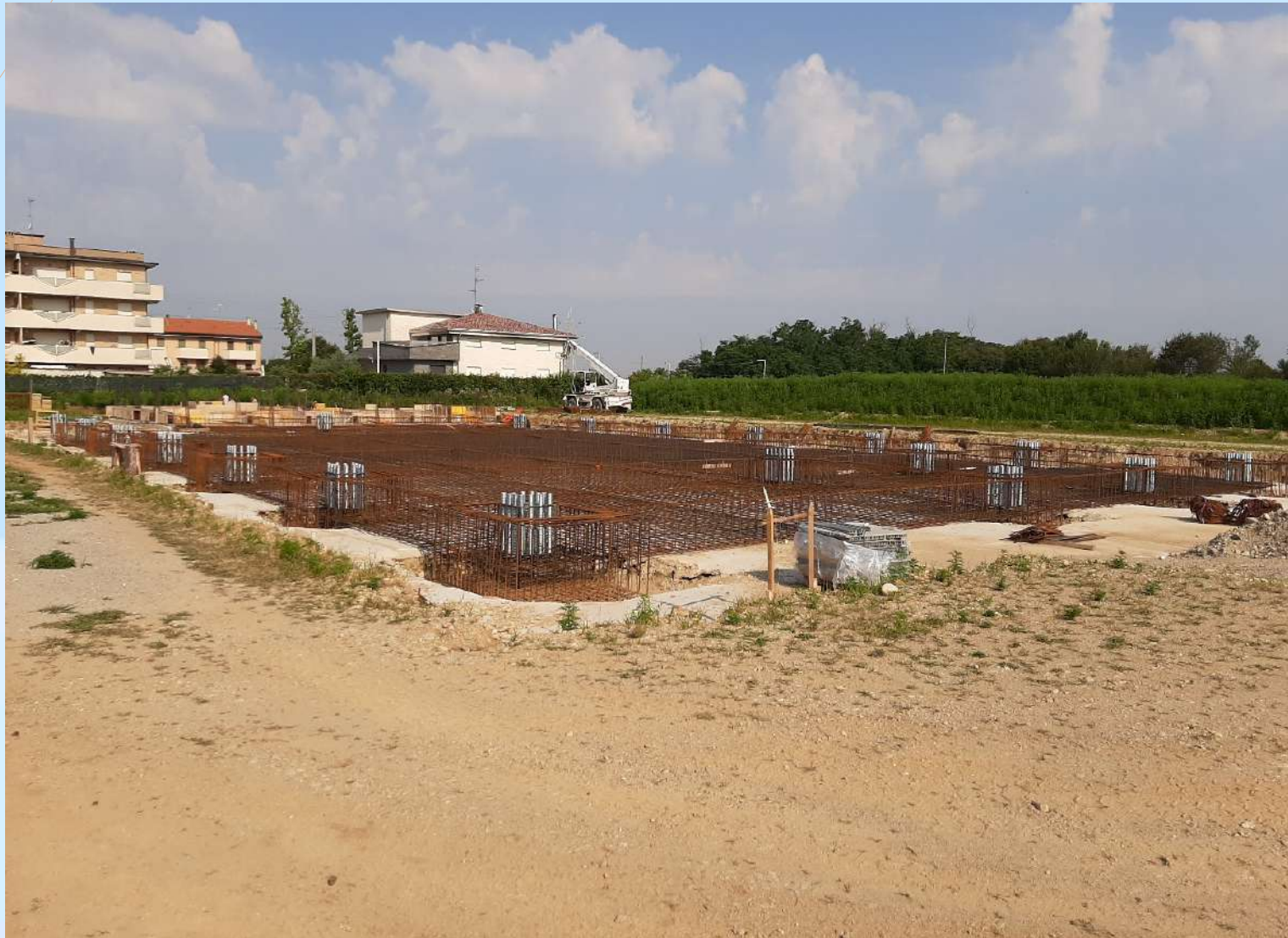
Posa armatura delle fondazioni
