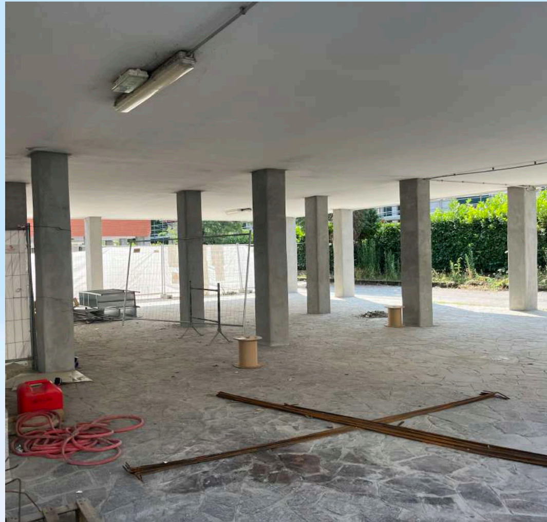
Consolidamento statico pilastri piano pilotis con materiale in fibra di acciaio e geomalta
