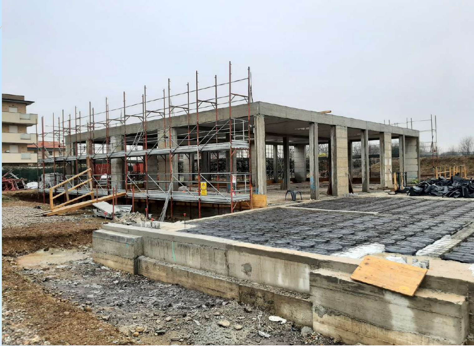
Realizzazione solaio di copertura del locale spogliatoi
