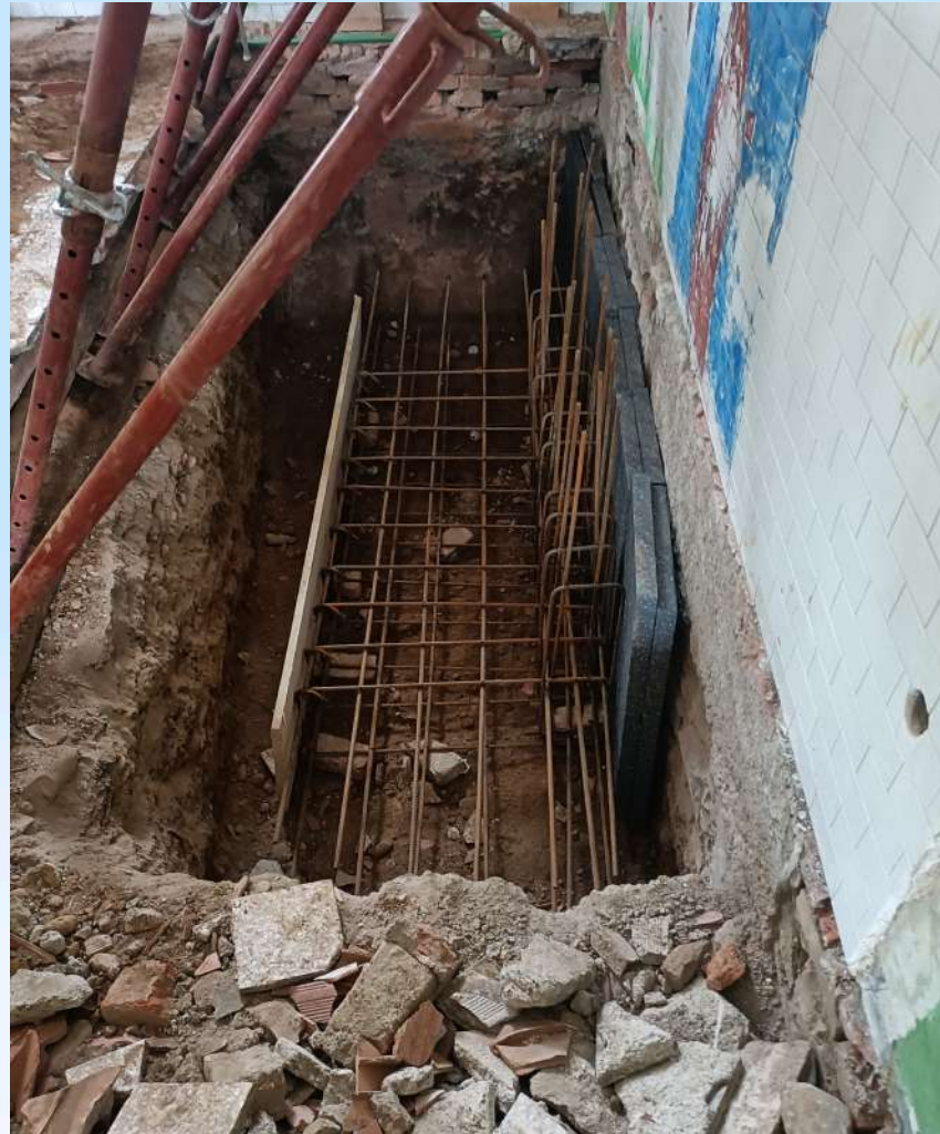
Posa armatura per consolidamenti strutturali nell'ala storica
