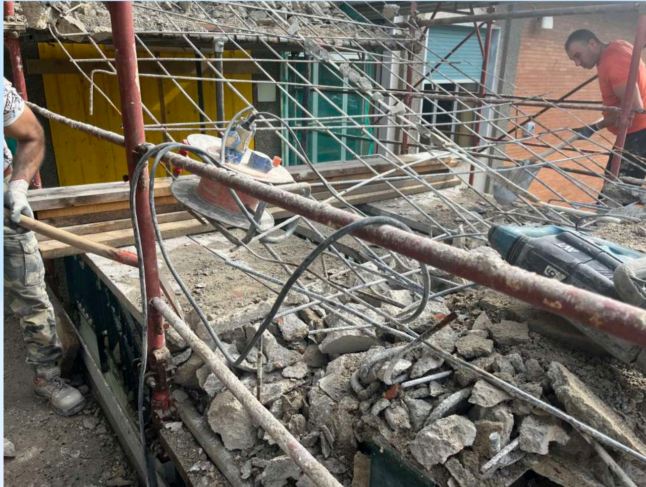
Demolizione scala di accesso
