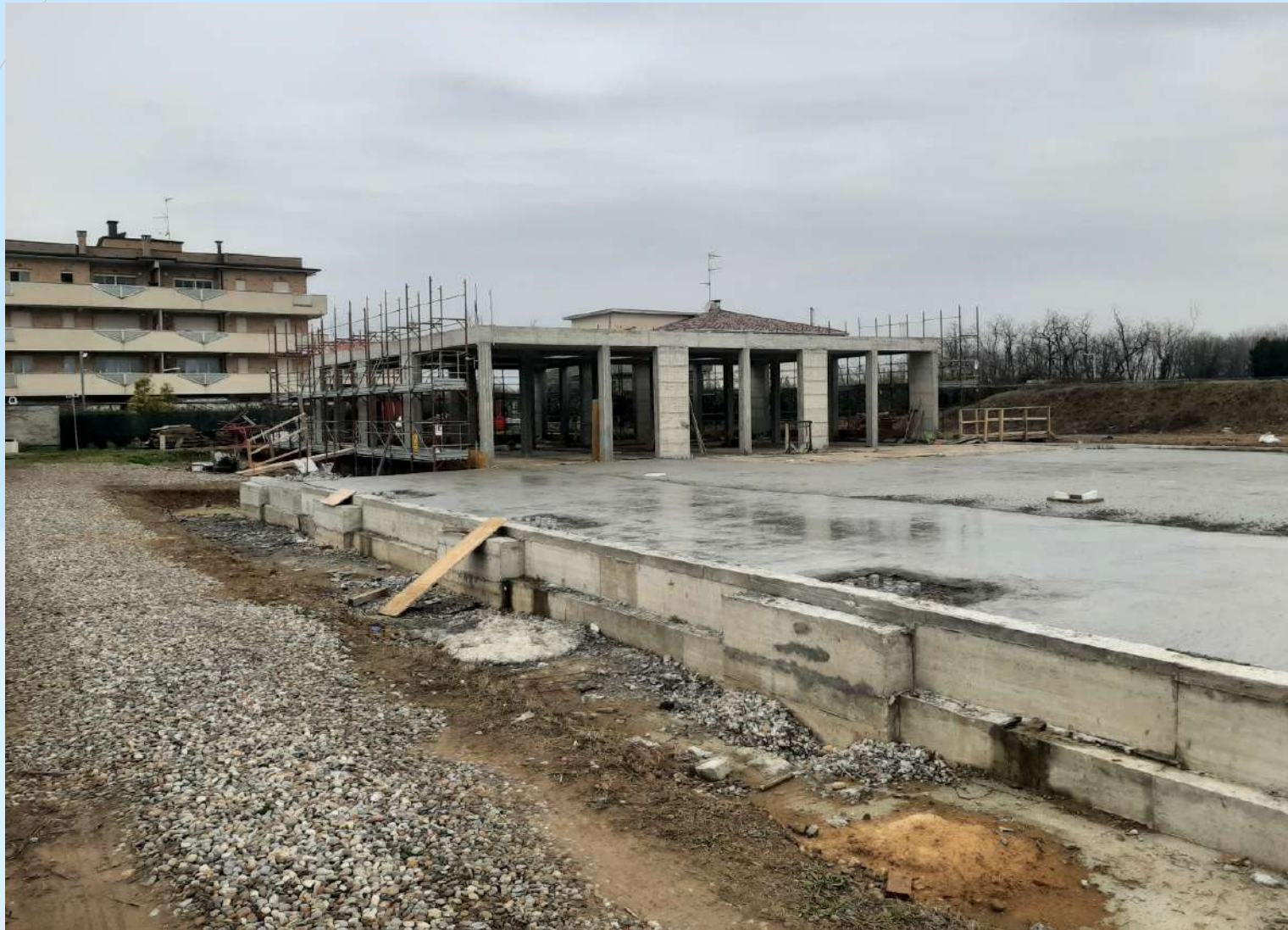
Realizzazione massetto del locale palestra
