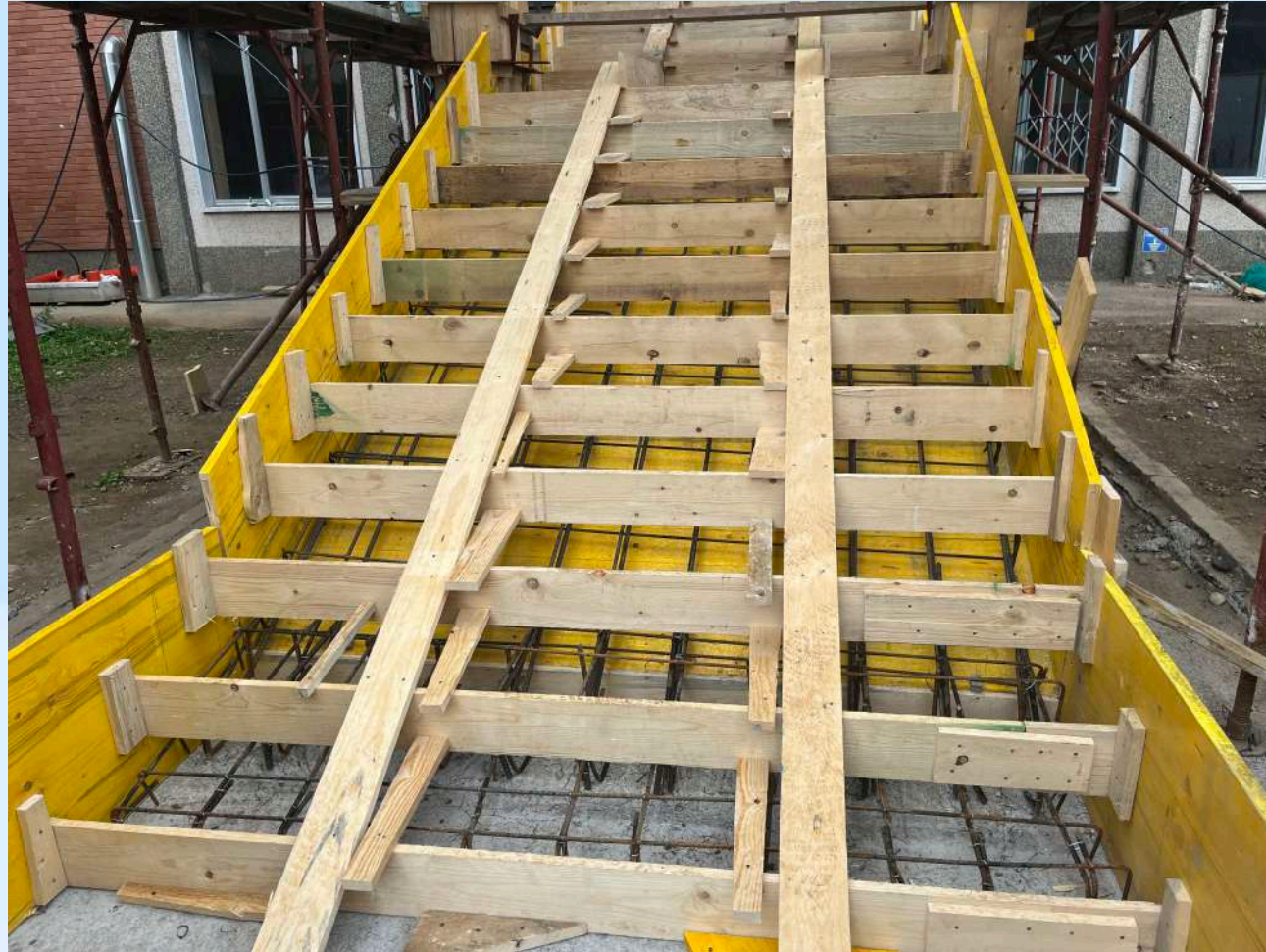
Realizzazione struttura nuova scala di accesso
