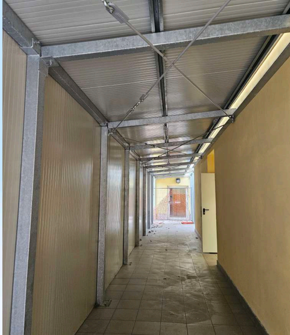
Montaggio pannelli del corridoio coperto di collegamento fra scuola, mensa e palestra
