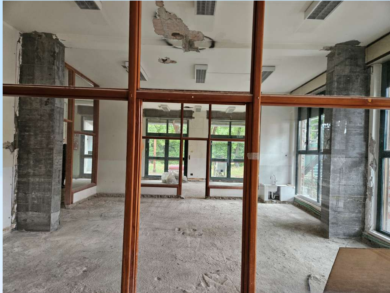
Interventi di consolidamento della struttura esistente al piano rialzato
