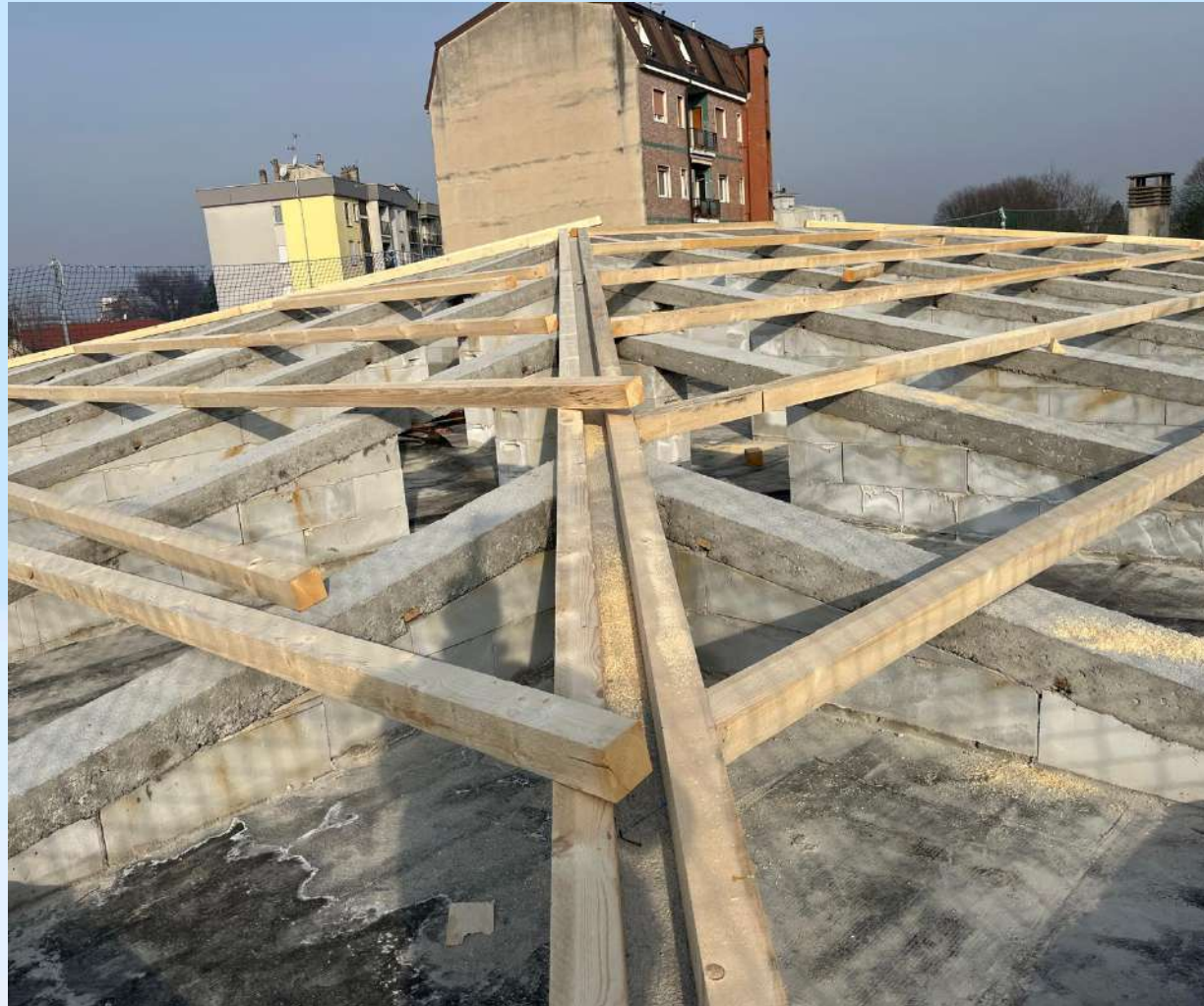
Posa arcarecci al secondo piano
