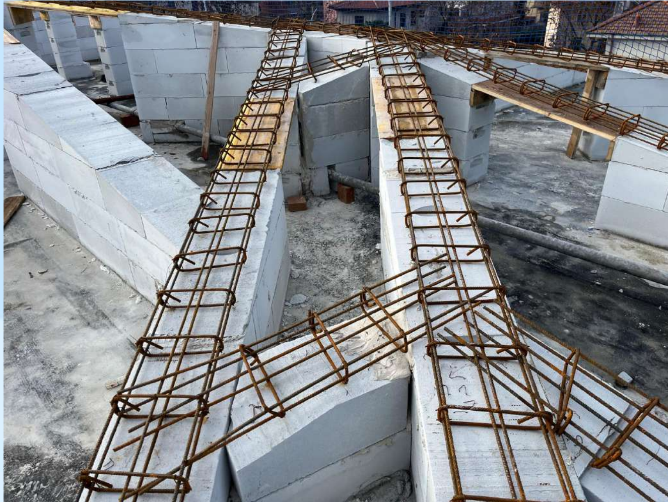
Realizzazione nuovi muretti di sostegno copertura e cordoli superiori armati
