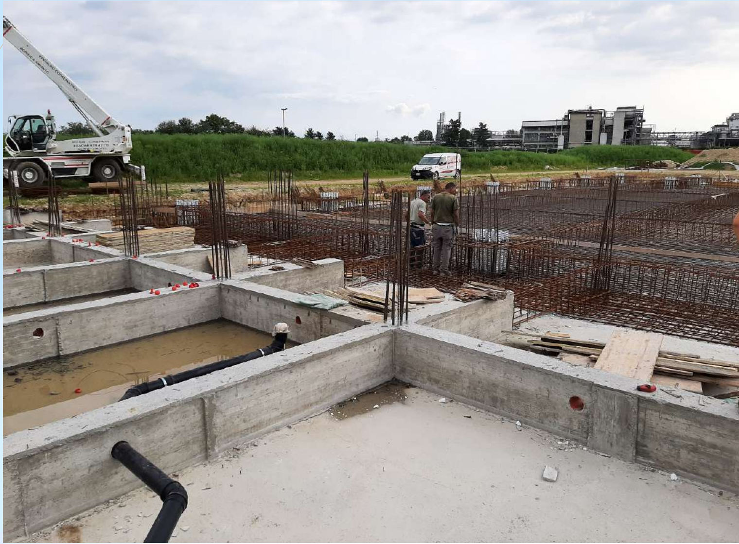
Disarmo delle strutture di fondazione del locale spogliatoi e fine posa armatura delle fondazioni del locale palestra
