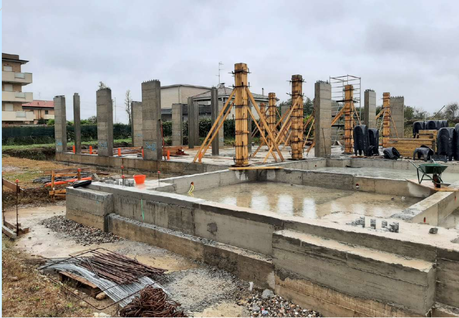
Disarmo della struttura in elevazione del locale spogliatoi
