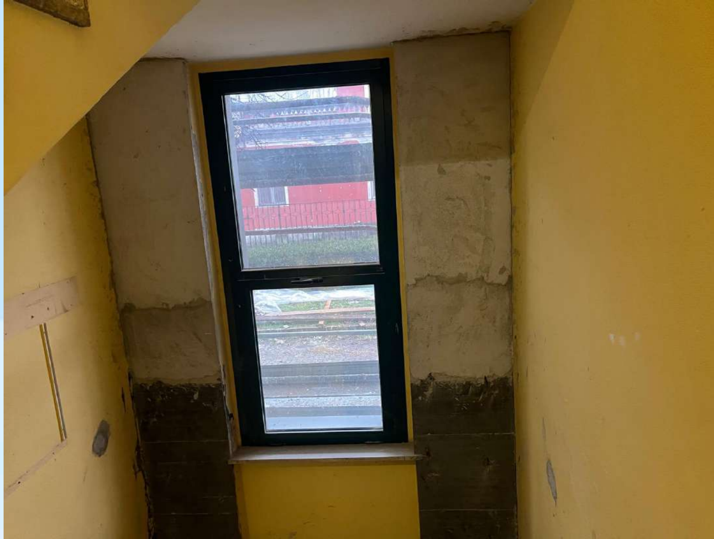
Interventi di consolidamento della muratura esistente del vano scala
