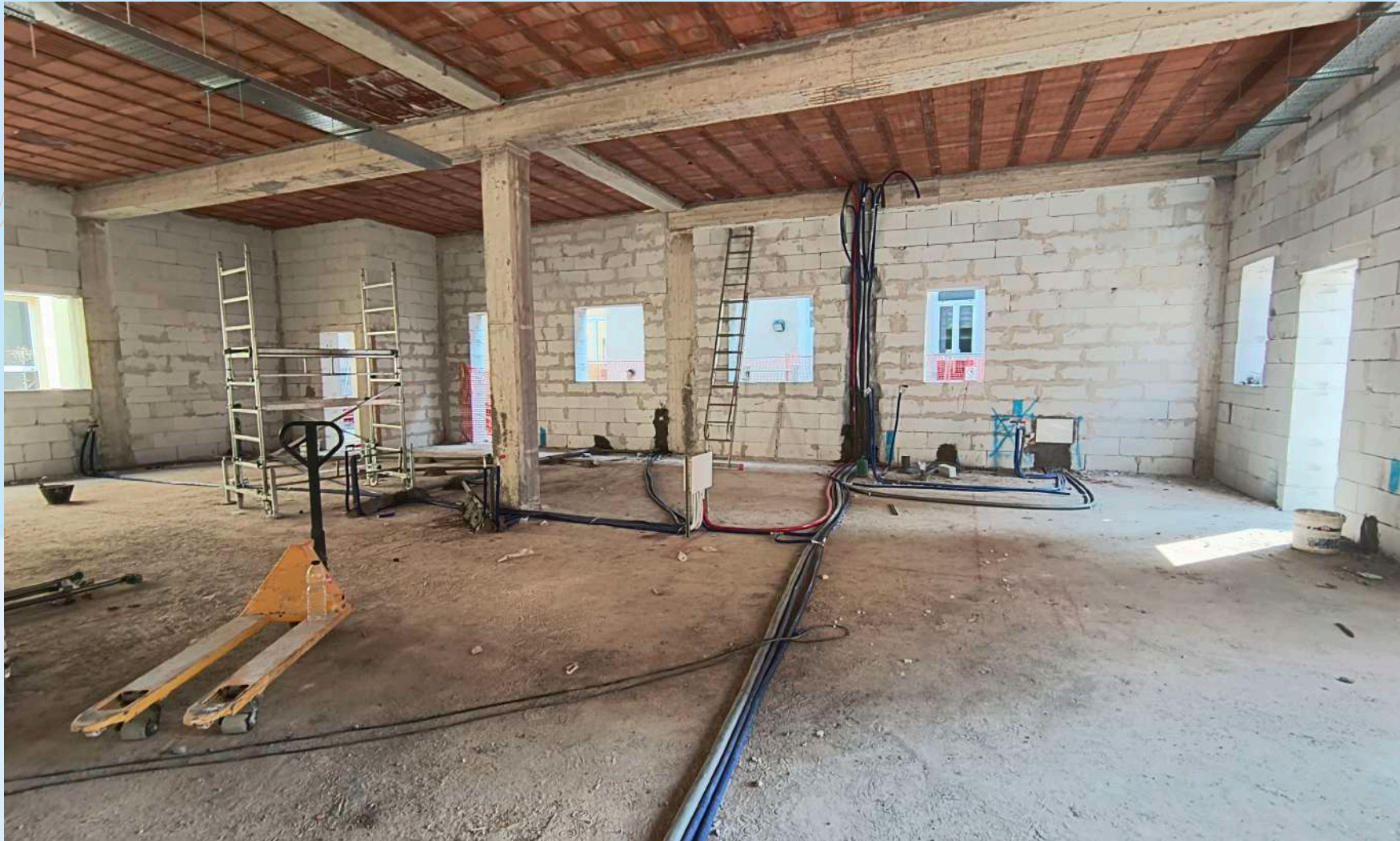
Realizzazione muratura perimetrale e posa impianti
