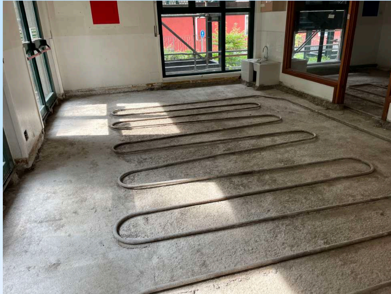
Sostituzione impianto di riscaldamento radiante a pavimento esistente
