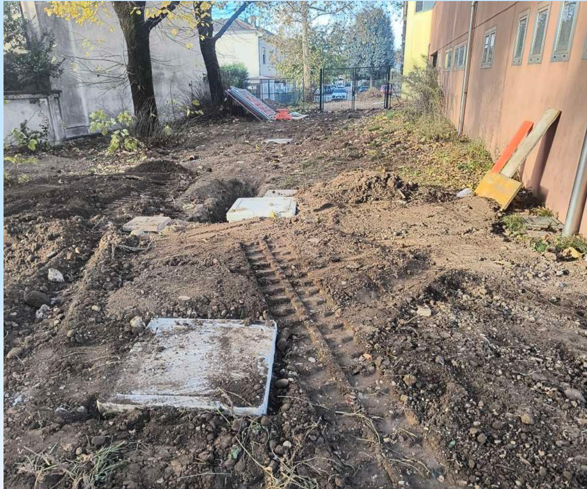
Realizzazione nuovo tratto fognatura mensa e rifacimento tratto palestra e collegamento alla nuova linea
