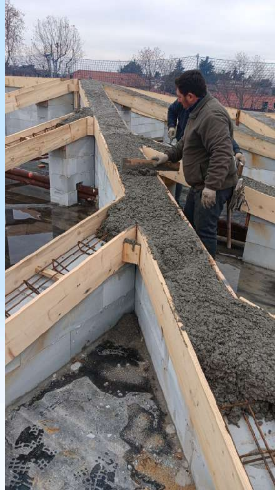
Realizzazione nuovi muretti di sostegno copertura e cordoli superiori armati
