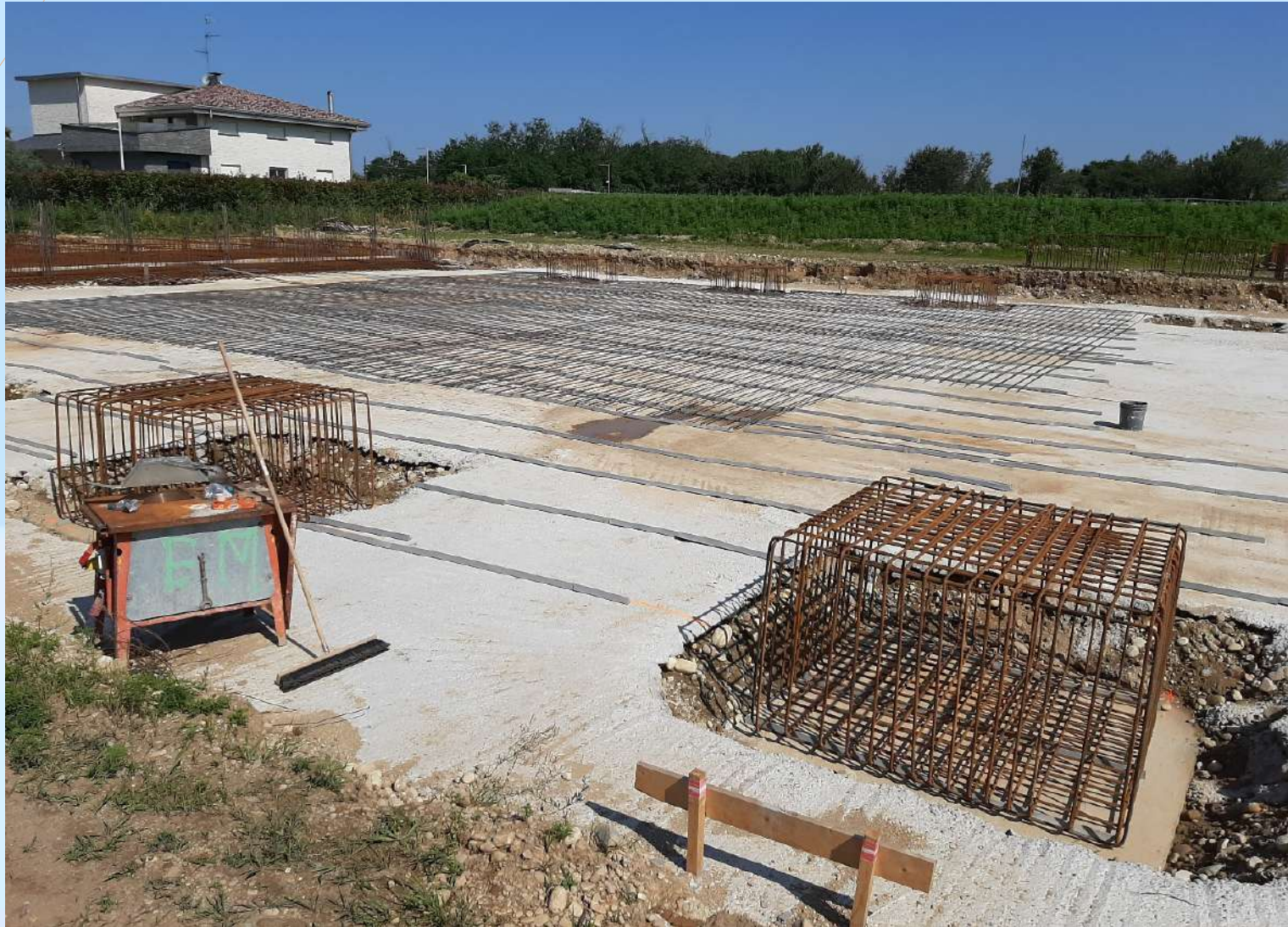
Posa armatura delle fondazioni
