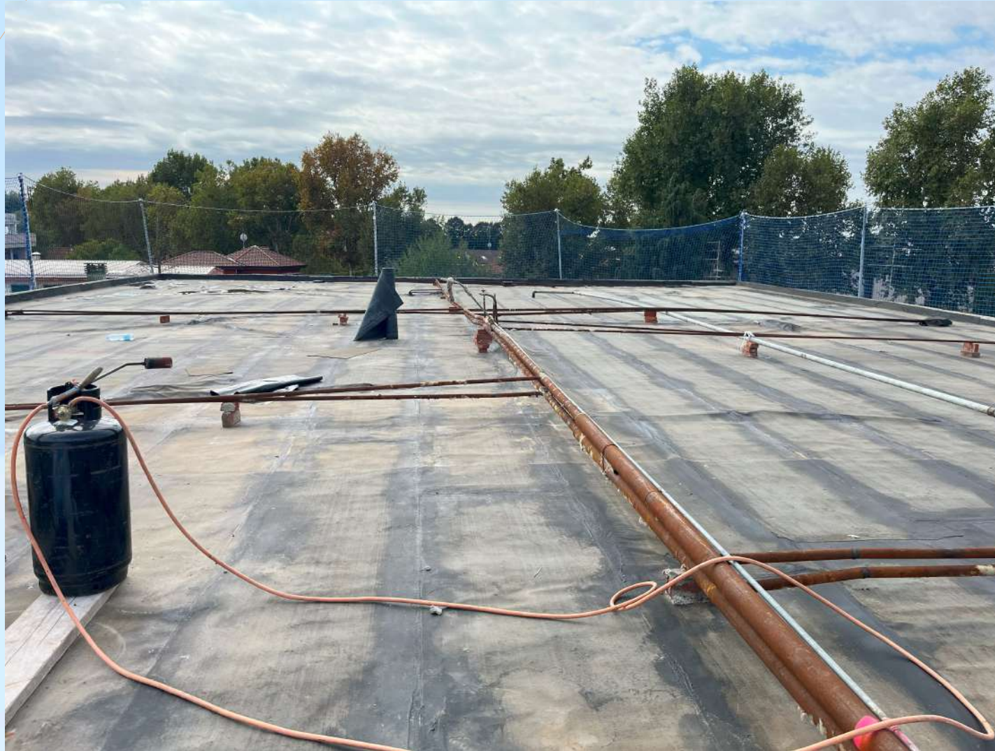
Posa guaina impermeabilizzante
