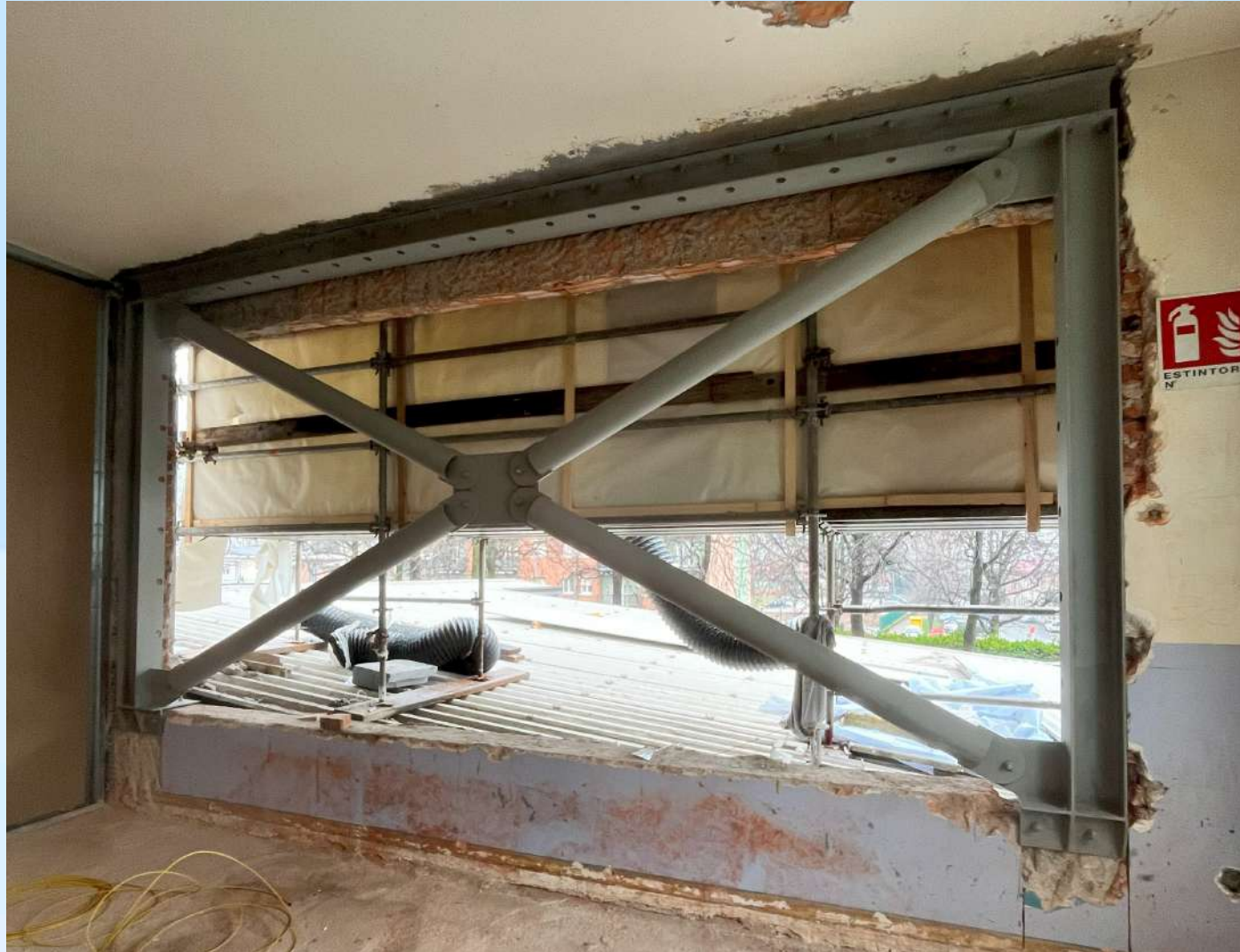
Interventi di consolidamento della struttura esistente al primo piano
