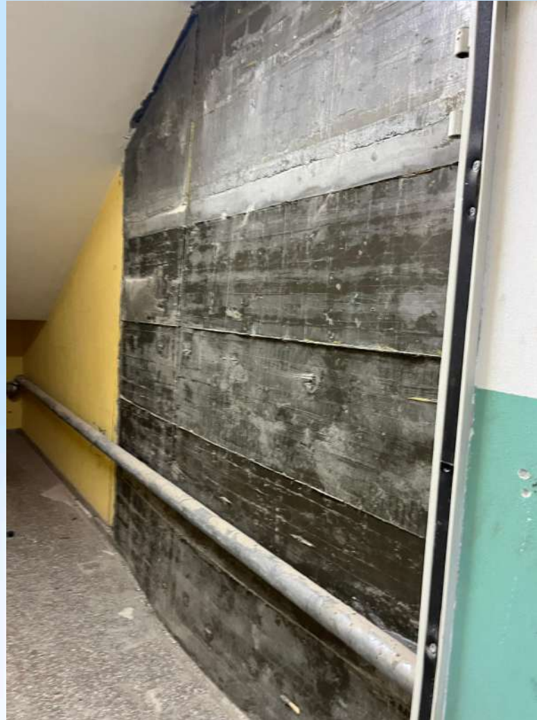
Interventi di consolidamento della struttura esistente al piano seminterrato
