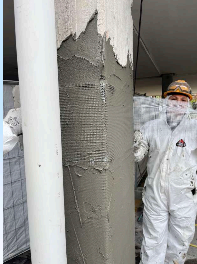
Consolidamento statico pilastri piano pilotis con materiale in fibra di acciaio e geomalta
