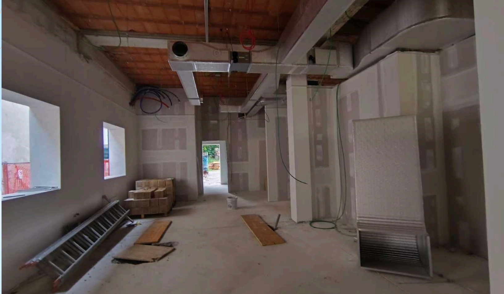
Realizzazione impianto meccanico e posa controsoffitto
