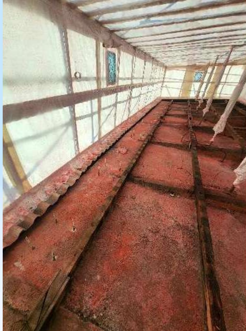
Rinvenimento materiale FAV in copertura e installazione capannina per bonifica
