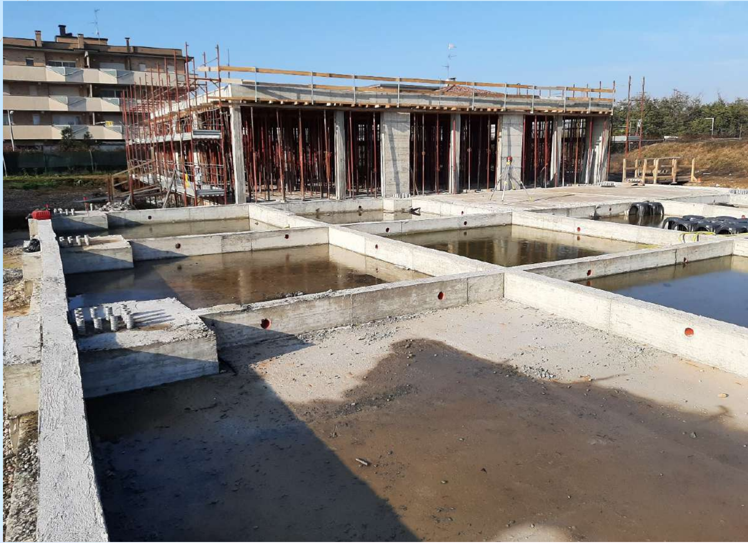
Realizzazione solaio di copertura del locale spogliatoi
