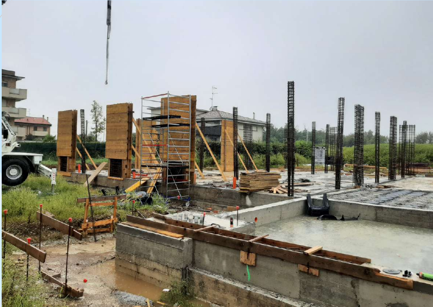
Posa armatura e casseformi per getto della struttura in elevazione del locale spogliatoi
