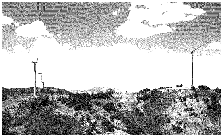
In Basilicata. Parco eolico Brienza da 18 MW
